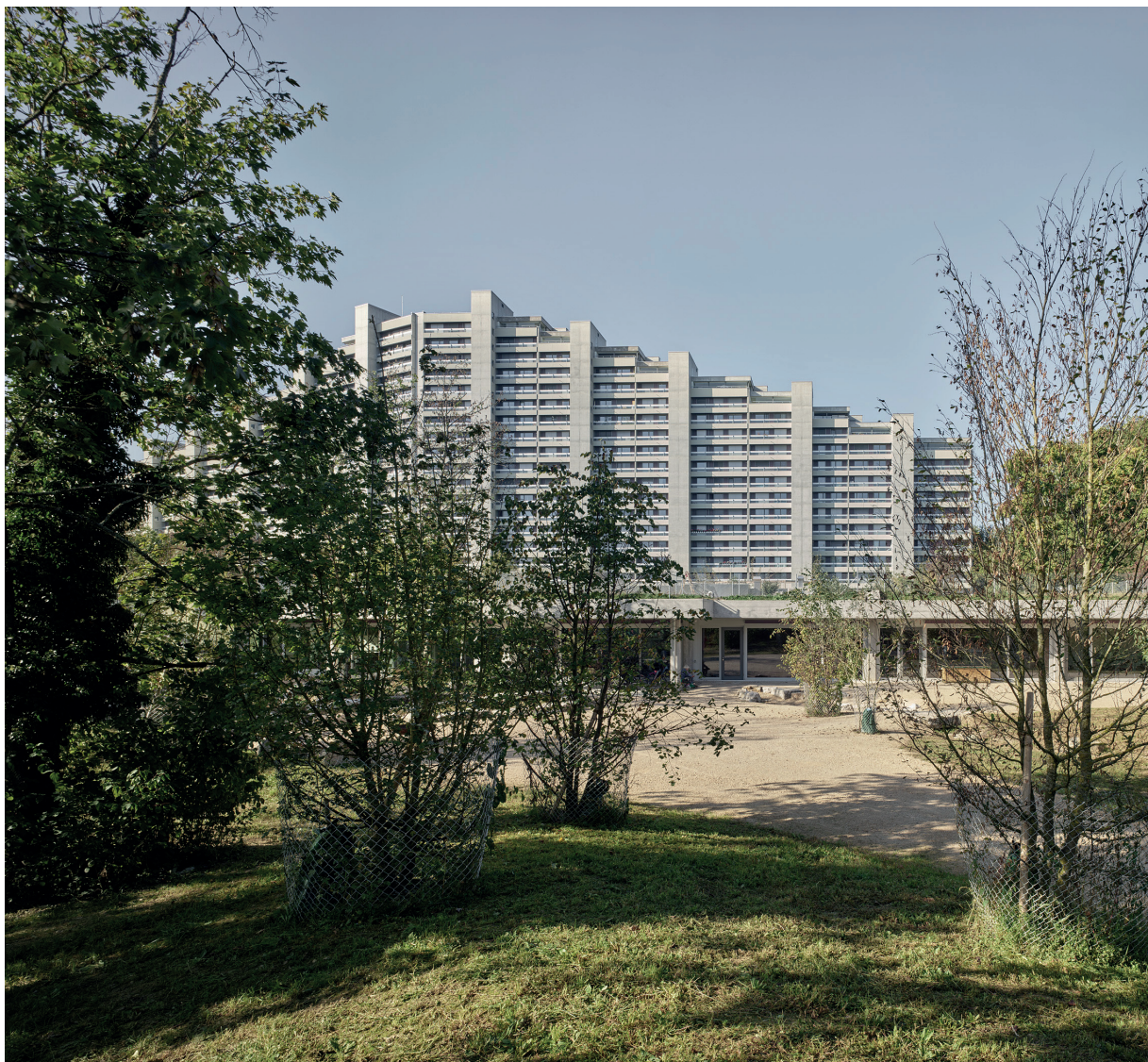
Energetische Sanierung Tellli B & C, Aarau (©Karin Gauch, Fabien Schwartz)
